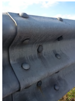
Figura 3 – Esempi di non integrità dei dispositivi di sicurezza
