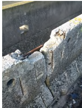
Figura 3 – Esempi di non integrità dei dispositivi di sicurezza
